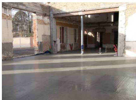
Réalisation de la chape
