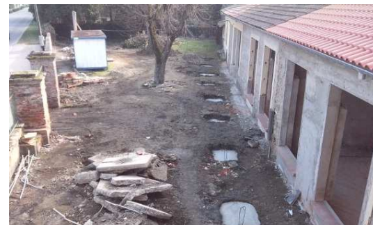
Réhabilitation de la future cour et du mur d'enceinte
