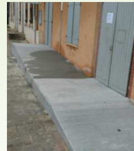
Travaux en cours
