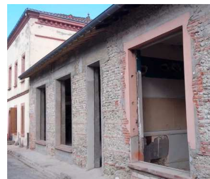
Préparation des encadrements pour les futures menuiseries
