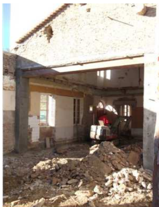
Démolition à la mini-pelle des cloisons, sols et plafonds
