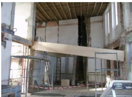
Mise en place des nouvelles poutres
