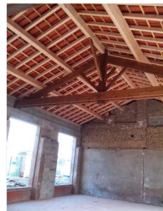
Rénovation de la charpente
