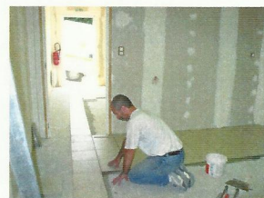
Pose du carrelage dans les vestiaires
