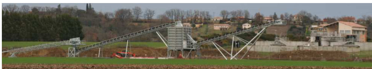
Les changements de direction de la bande transporteuse sont identifiables du fait des dispositifs comme celui-ci, entre les sites de Pissou et Tanéria. Le même est présent à côté de la RD6 après le passage sous tunnel. Ci-dessous la zone de chargement des camions et de stockage, site de Pissou en face de la station d'épuration.
